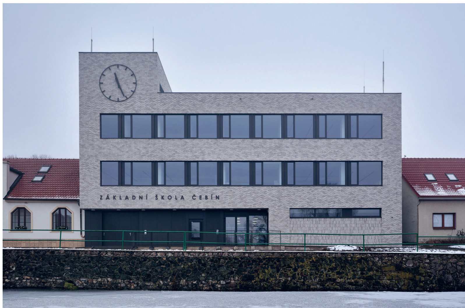
Přestavba objektu bývalé Jednoty na základní školu, Čebín (2025)
