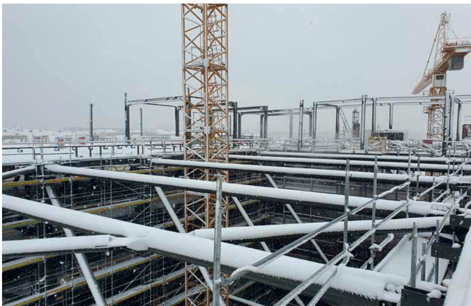
▲ Obr. 13 Montáž technologické nadstavby
