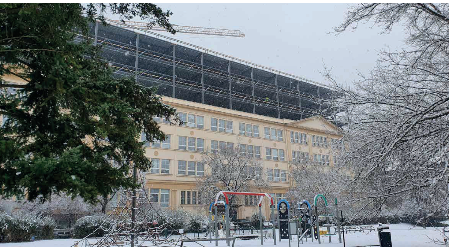
▲ Obr. 1 Cerit Science Park II v Brně – výstavba ocelové konstrukce
