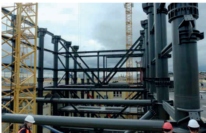
▲ Obr. 7 Pohled na ocelovou konstrukci nad atriem budovy, +19,500 až +30,200
