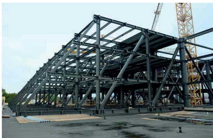
▲ Obr. 8 Postupná montáž konzol
