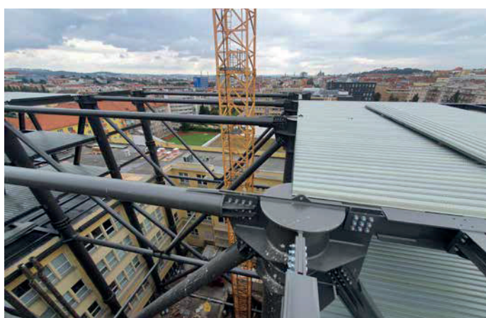
▲ Obr. 10 Montáž trapézových plechů na konzolách
