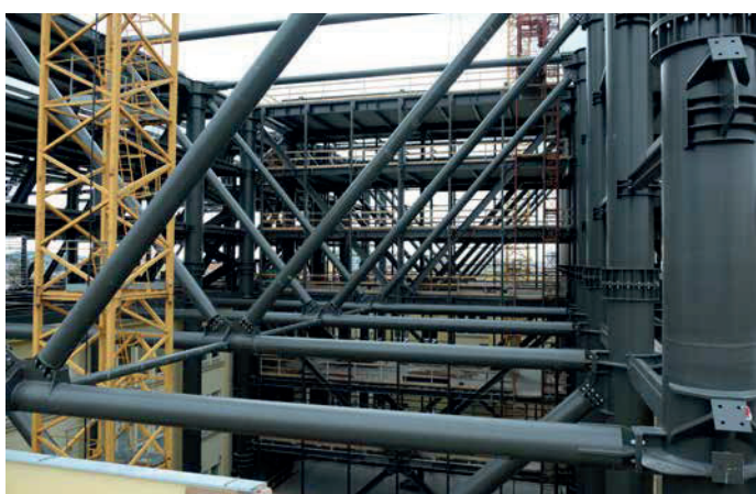
▲ Obr. 9 Pohled na spojovací krček po vybetonování desek
