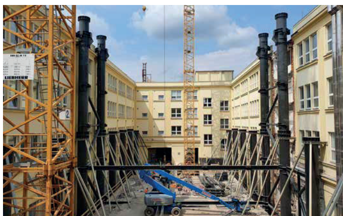
▲ Obr. 5 Montáž prvních částí sloupů
