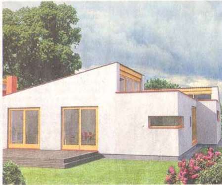
Dům v Křížanovicích (2002 - 2005, před dokončením)
